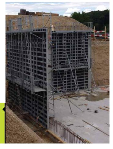
A cofragem Forteko® é constituída por uma armação metálica leve em aço especial e uma estrutura de reforço para evitar a flexão dos painéis. A superfície de cofragem que encaixa na armação é de contraplacado de 18mm de espessura com duas faces revestidas com filme fenólico de 220g/m² para assegurar a boa qualidade no acabamento de betão e uma maior durabilidade dos painéis.
