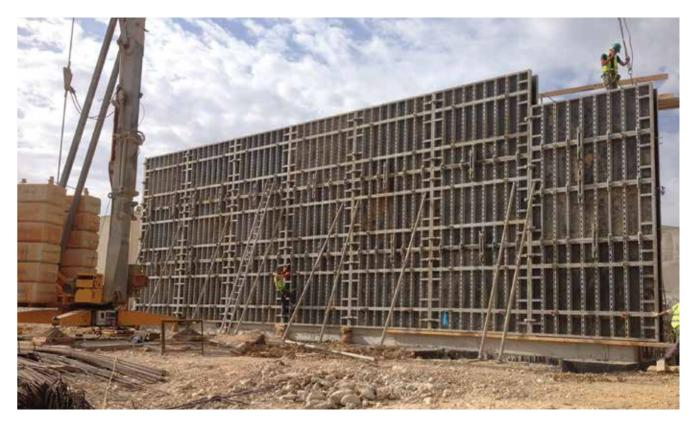
de cofragem vertical Forteko® é necessário utilizar fechos fixos. Estes componentes servem para unir dois painéis com aperto e ao mesmo tempo alinhar dois painéis vizinhos. Estes elementos podem ser usados nos diferentes tipos de ligações: painéis verticais e horizontais.
