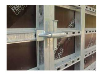
Os fechos de alinhamento permitem fixar e alinhar os painéis entre si. Estes podem ser alinhados de forma automática, e possibilitam a movimentação de um conjunto de painéis pré-montados com o auxílio da grua.
